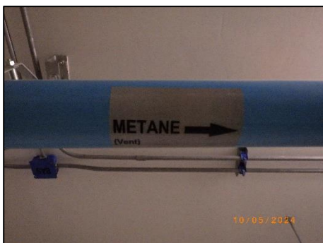
รูปที่ 2-16 ท่อระบายก๊าซมีเทนไปบำบัดโดยวิธี Biological Oxidation
