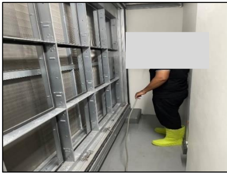
รูปที่ 2-33 การทำความสะอาดระบบเครื่องปรับอากาศ
