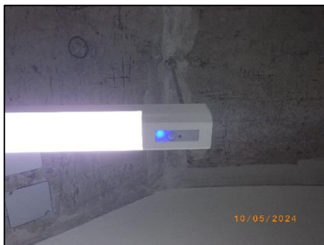
หลอดไฟตรวจจับความเคลื่อนไหว บริเวณบันไดหนีไฟ
