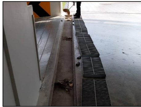
รูปที่ 2-21 การทำความสะอาดระบบท่อระบายน้ำ
