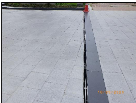
รูปที่ 2-20 ระบบท่อระบายน้ำ รองรับน้ำหลาก
