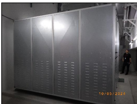
รูปที่ 2-10 พัดลมระบายอากาศ อาคารจอดรถ
