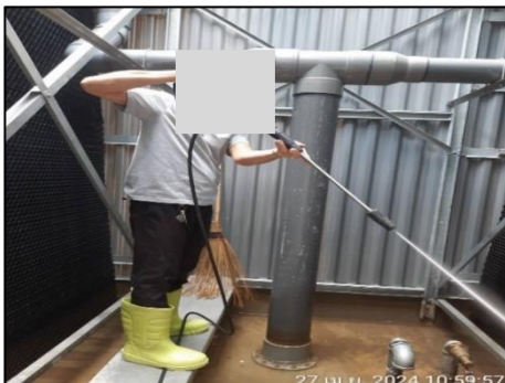
รูปที่ 2-36 การทำความสะอาดหอผึ่งเย็น
