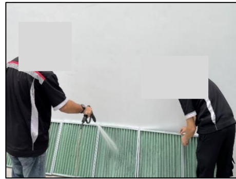
รูปที่ 2-33 การทำความสะอาดระบบเครื่องปรับอากาศ
