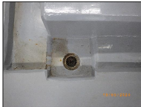
ตะแกรงครอบรูท่อระบายน้ำทั้งภายในอาคาร
