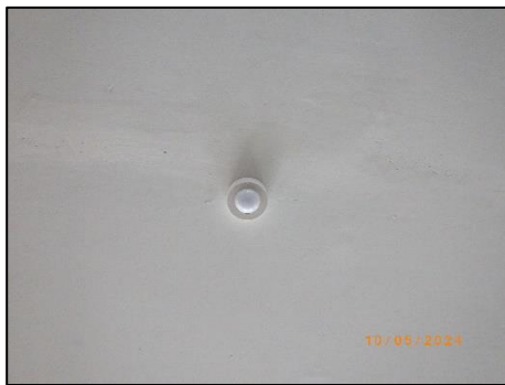
เซ็นเซอร์ตรวจจับความเคลื่อนไหว บริเวณลานจอดรถ
