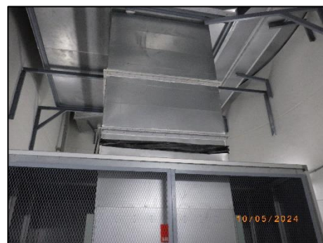
รูปที่ 2-10 พัดลมระบายอากาศ อาคารจอดรถ
