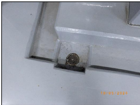
ตะแกรงครอบรูท่อระบายน้ำทั้งภายในอาคาร
