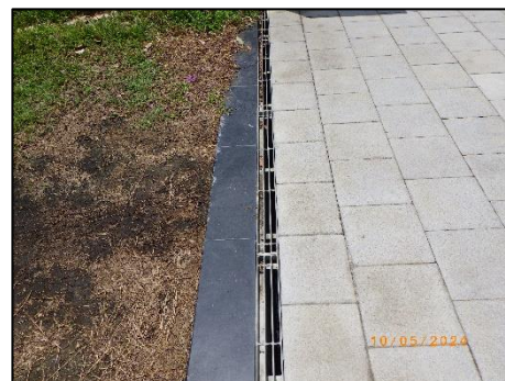
รูปที่ 2-20 ระบบท่อระบายน้ำ รองรับน้ำหลาก
