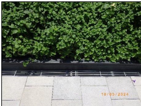
ตะแกรงครอบท่อระบายน้ำฝนภายนอกอาคาร
